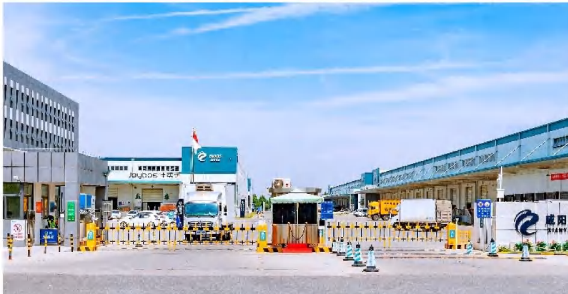
宝湾物流首个“智慧空间”试点园区——西安空港宝湾物流园
