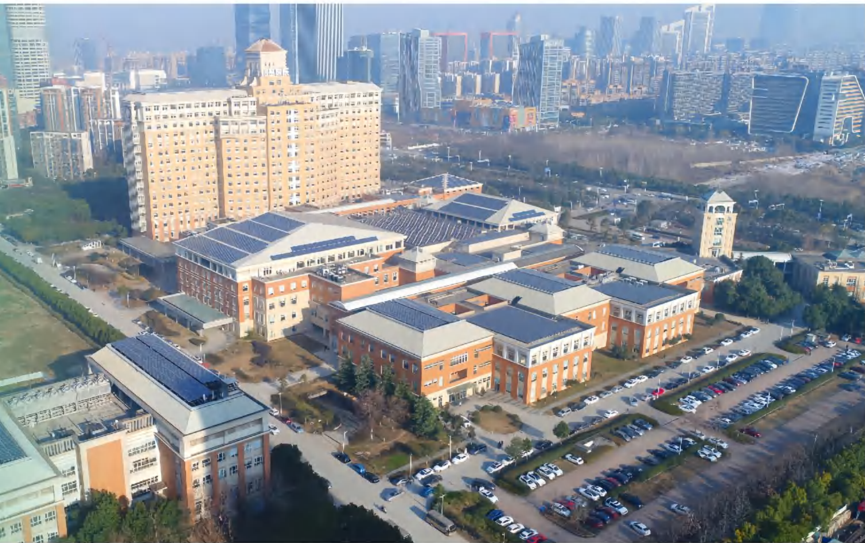
南京明基医院屋顶分布式光伏项目
