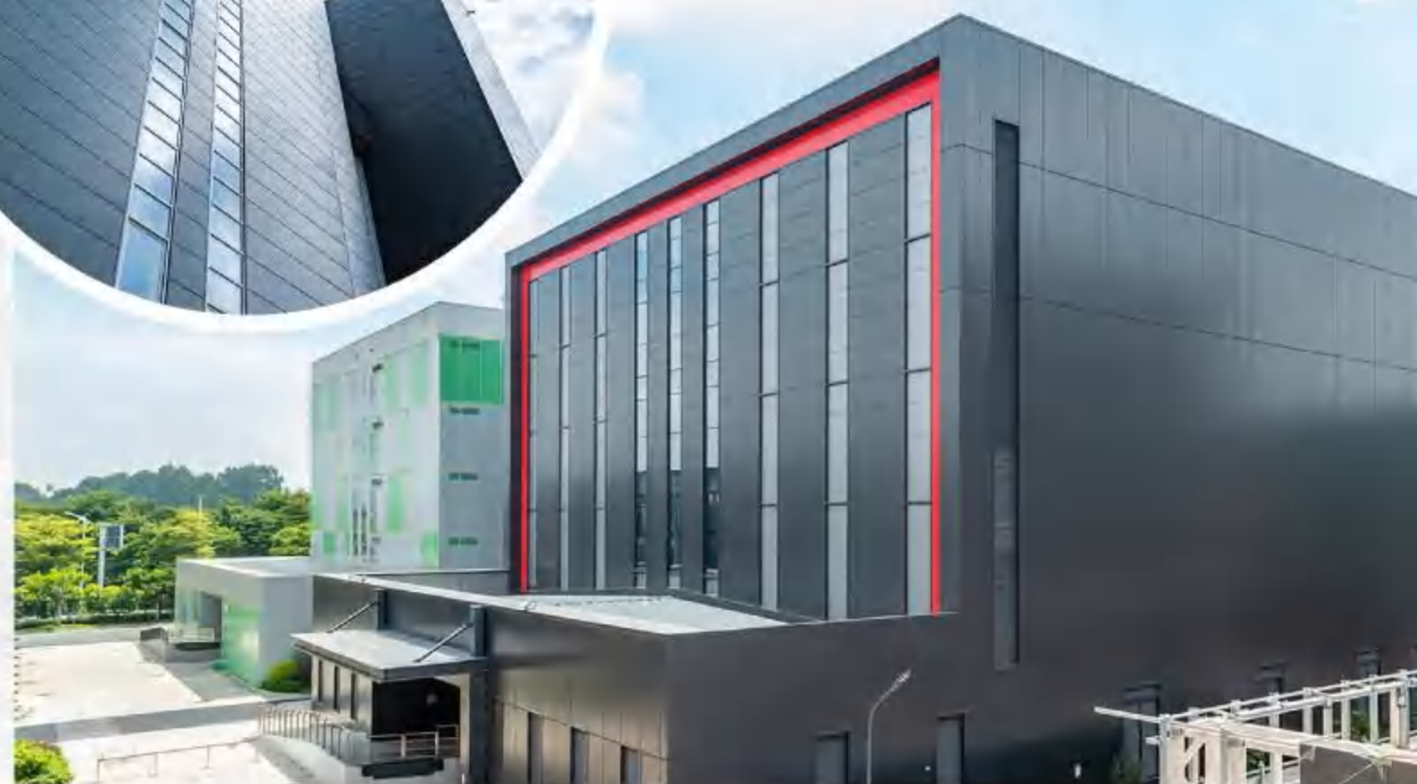
赤晓科技产品应用于华为松山湖团泊洼IDC项目
