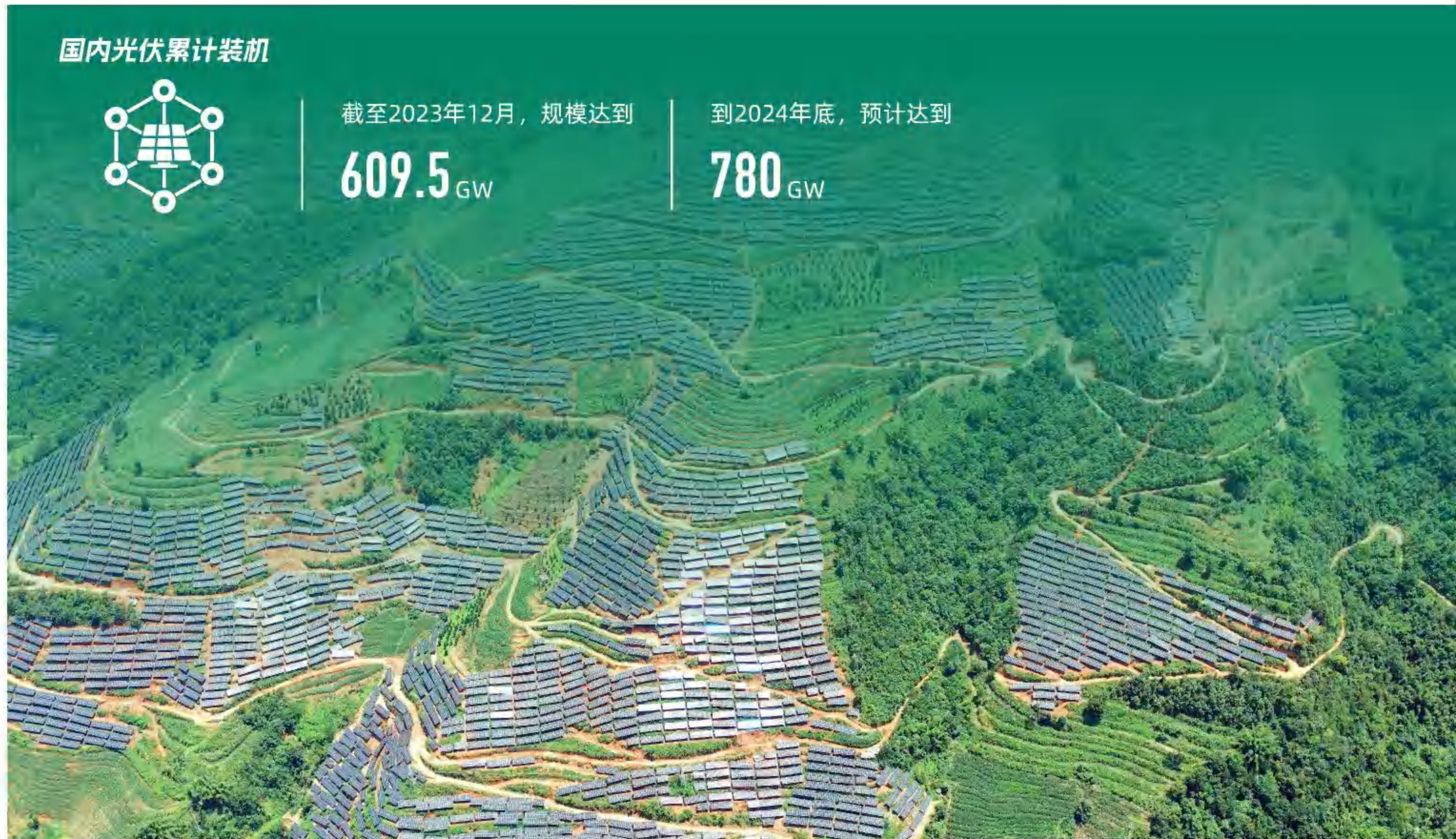
镇康县一期“农光互补”光伏发电项目
