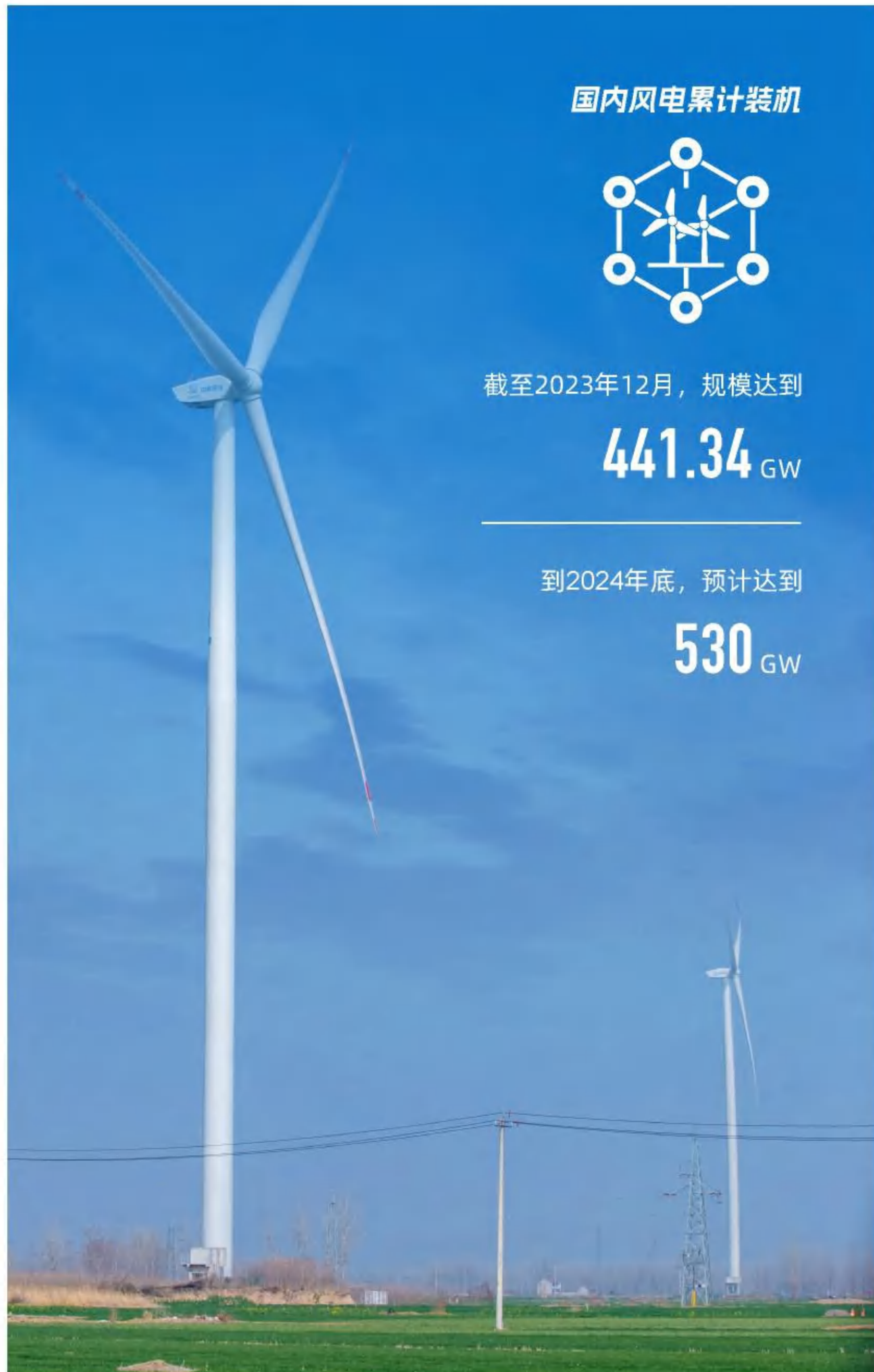
中国核能科技睢宁230MW风力发电项目
