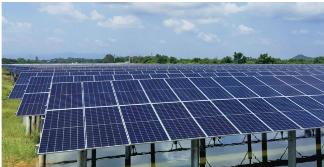
中国南山投资的阳江 50MW 渔光互补光伏项目
