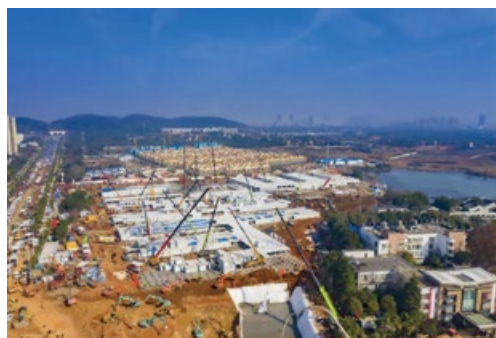
火神山医院隔离箱房建设
